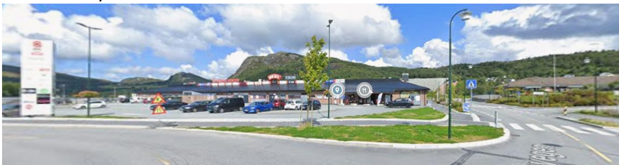
Bilde fra avkjøring i rundkjøring øst. Aksdal Senter i front og Kirken vises i bakgrunnen til høyre.
