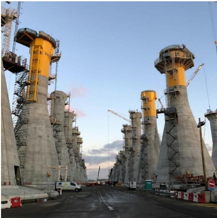
Figur 9: Døme på bundfaste fundament til vindturbinar.
