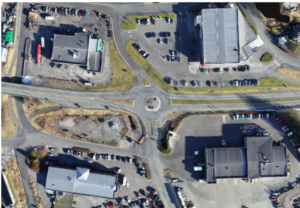
Figur 1.1: Dronefoto Frakkagjerdkrysset. Kilde: Statens vegvesen
