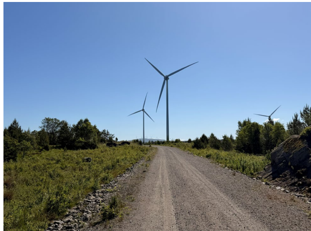
Figur 4-9 - Foto fra eksisterende anleggsveg
