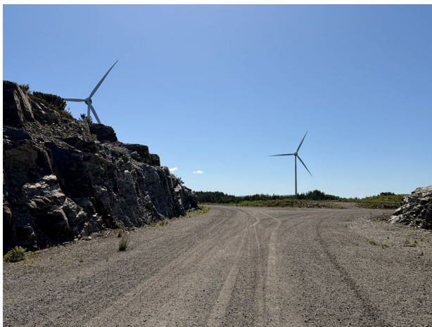
Figur 6-1 - Foto fra eksisterende anleggsveg
