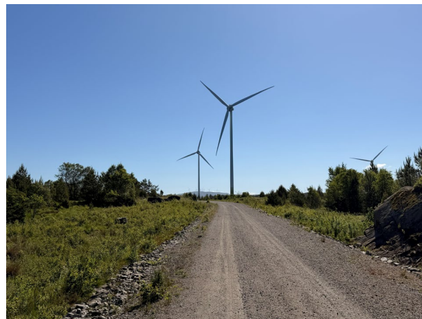
Figur 6-2 - Foto fra eksisterende anleggsveg
