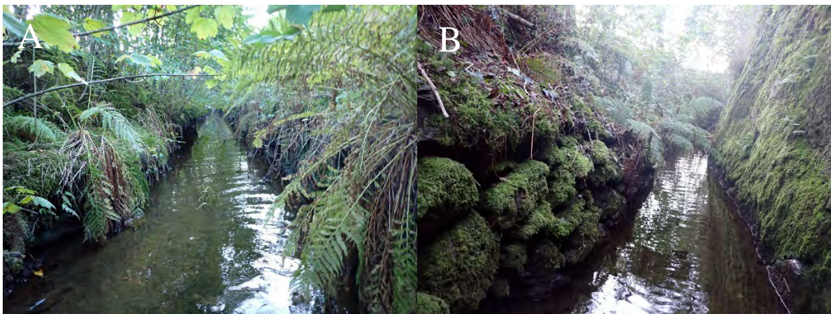
Figur 10. A: Kanalisert og utrettet parti (segment 2) med lite variasjon i substrat og strømningsmønster. B: Kanalisert og utrettet parti (segment 4) med forbygning av eldre steinmur.
