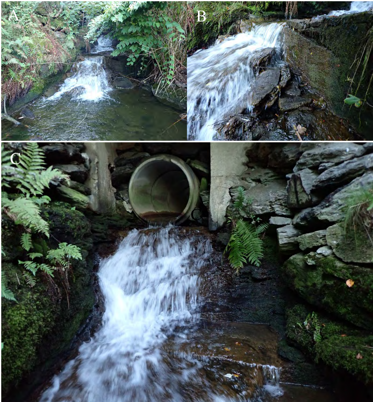
Figur 9. Vandringshinder i Tveitbekken. A: Betongplatå i segment 1. Oppstrøms platået kan man skimte kulverten vist i bilde C. B: Haug av stein og betong foran betongplatået. C: Bratt fjellberg foran kulvert. Bunnen nedstrøms berget er flaten av betongplatået, hvor vanddybden er lav.
