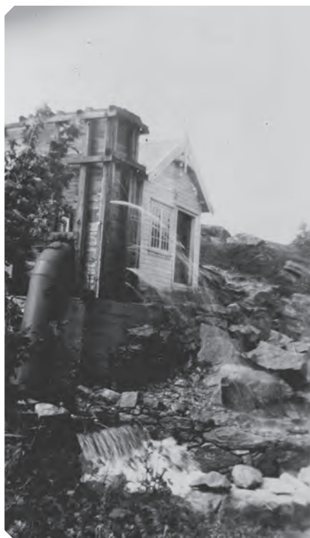
Kraftverket på Sagbakken er bygd av Stolt-Nielsen i 1916
