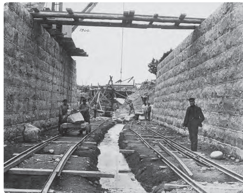
Bygging av Slusa
