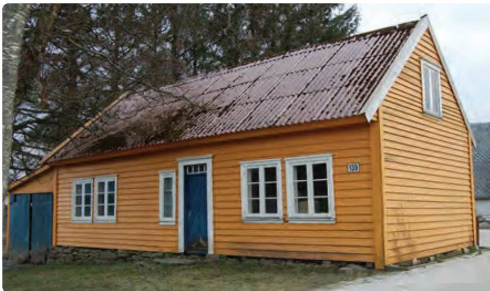
Våningshus på Nodland Tidleg 1800
