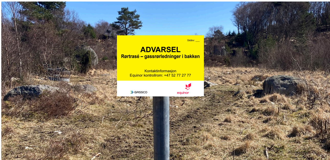
Merking langs rørledningstraséen.
