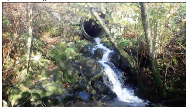
Figur 4.2. A) Nedre del av Vågsbekken er stort sett forbygd med steinmur. B) Rørene øverst i hovedløpet kan passeres på gunstige vannføringer. C) Dette røret og fossestryket er absolutt vandringshinder for fisk i sidebekken. D) Oppstrøms røret i sidebekken er det et nytt kunstig vandringshinder i form av en kulvert.
