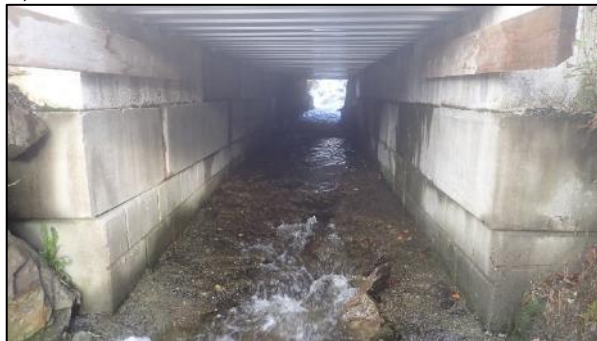
B) Kulvert i Glåmaskardbekken
