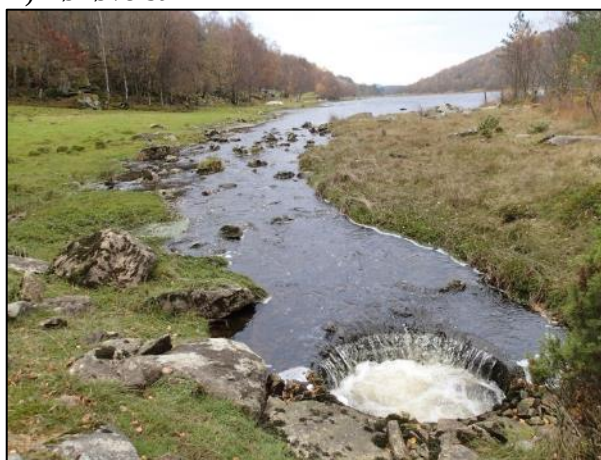
Figur 6.2. A) Kulverten under Skjoldastraumsvegen har naturlig substrat i elvebunnen og er ikke til hinder for fiskevandring. B) Et kort rør 430 m fra sjøen; passerbart for fisk. C) Utrettet og kanalisert område med lite kantvegetasjon like nedstrøms det vandringshindrende røret. Strekningen er, trass i inngrepene, bekkens beste gyteområde. D) I det øverste røret i bekken renner vannet inn via en kum. Nøkkjatjørna i bakgrunnen.
