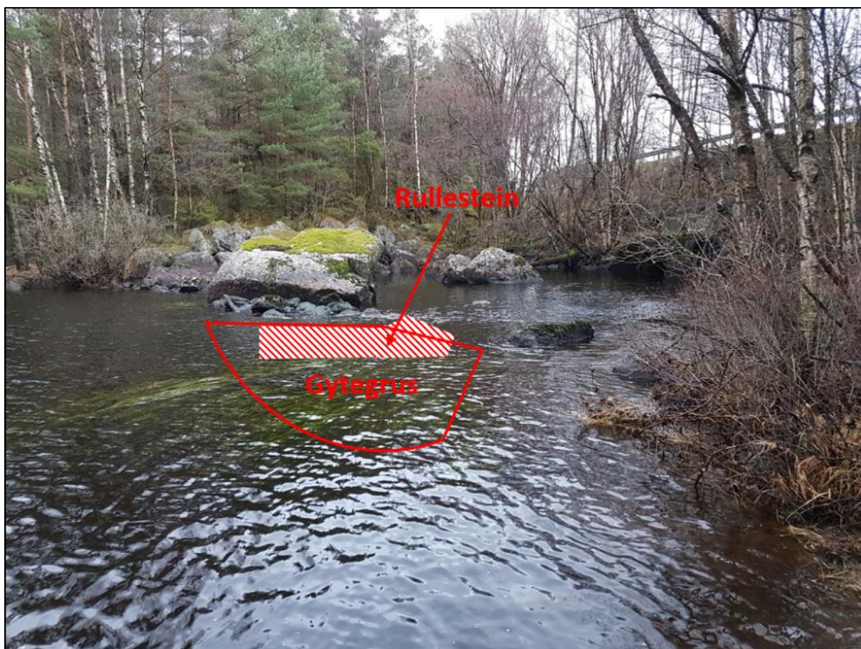
Figur 12.6. Strømsundet i nedre del av Pøyla. Omtrentlig område for utlegg av større rullesteiner for å heve dypålen er skravert. Området hvor det foreslås å legge ut gytegrus er omtrentlig markert med rød strek.
