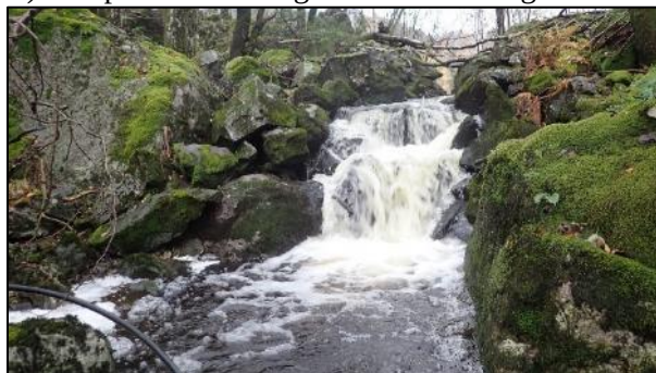
A) Temporært vandringshinder i Lindongbekken
