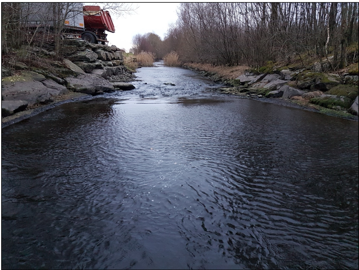
Figur 15. Aktuelt område for etablering av gyteområde. Bildet er tatt fra demningen på utløpet av Storavatnet. Kulpen nærmest demningen har betong i bunnen. Like nedenfor det korte stryket på bildet er det allerede et lite gyteområde.
