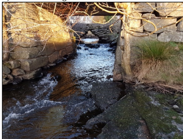
B) Kulverter i segment 3
