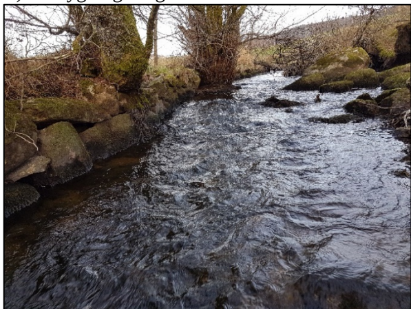
A) Forbygning i segment 8
