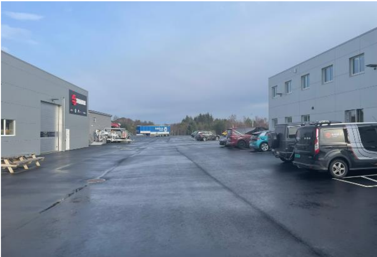
Foto: Deler av planområde, gnr. bnr. 1/151 sett fra sør mot nord. Lagerhall til venstre, kontorbygning til høyre.
