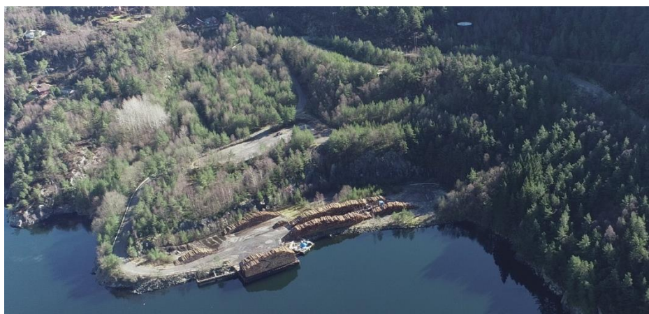
Figur 6 Ramsvika sett fra luft fra nordvest. Terrenget er tydelig opparbeidet til kai, og veien ned mot kaien er synlig i terrenget. Foto: Norconsult AS
