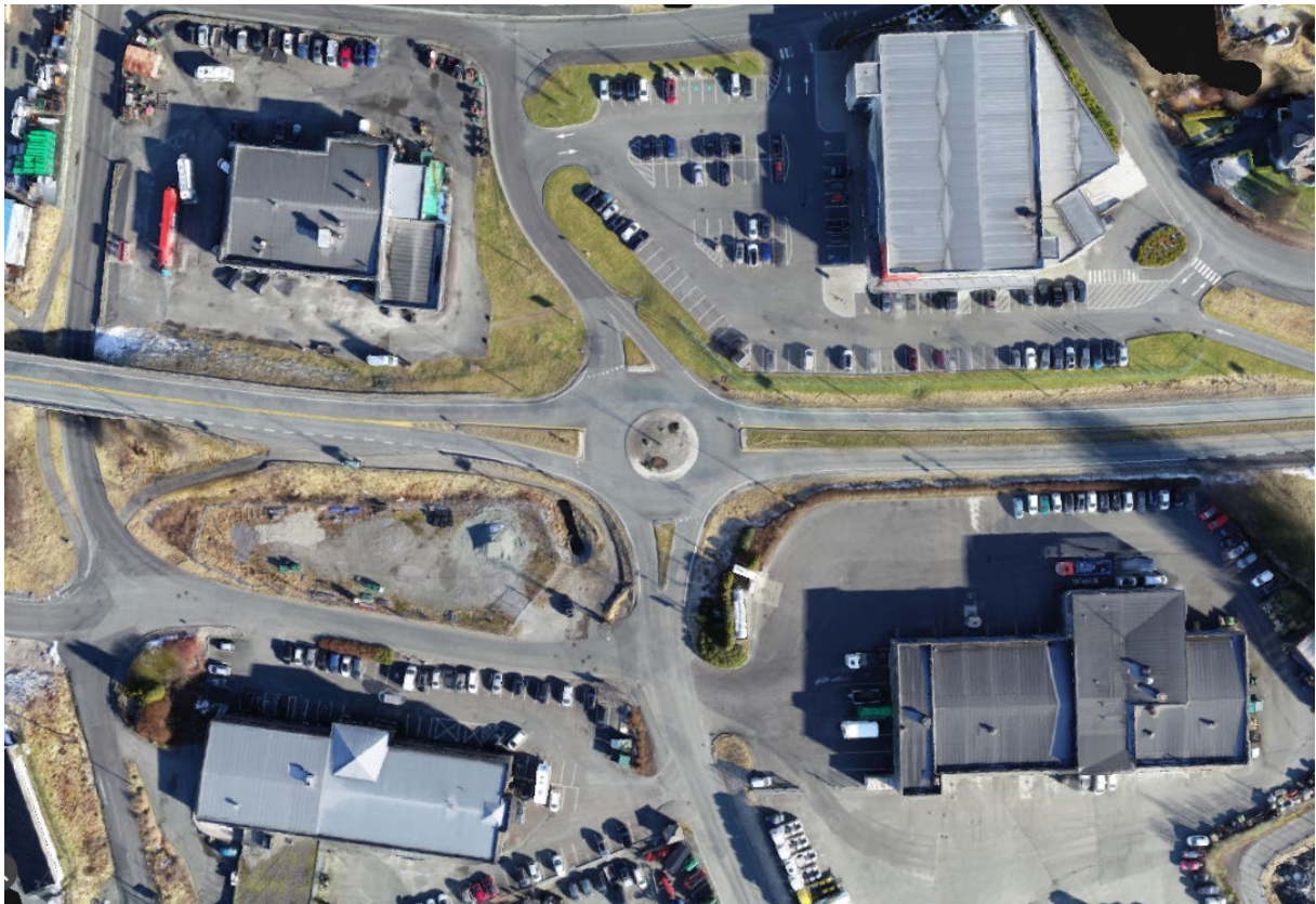
Figur 1.1: Dronefoto Frakkagjerdkrysset. Kilde: Statens vegvesen
