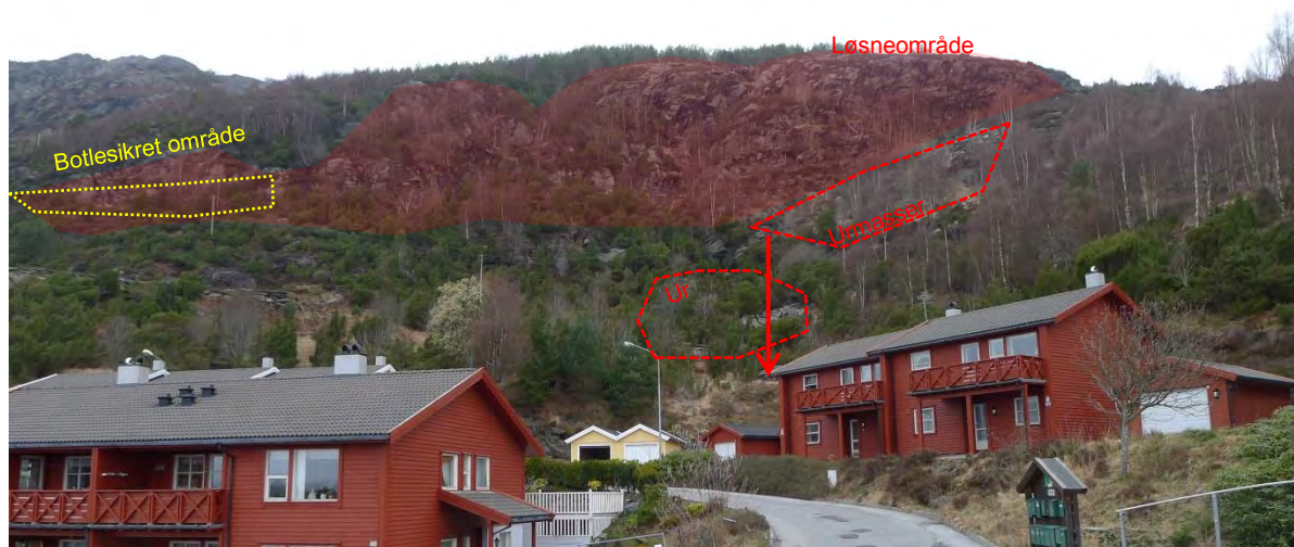
Figur 17: Potensielt løsneområde for steinsprang i øst. Deler av berghammeren er sikret med bergbolter (gul stiplet). Lengste registrerte utløp av steinsprang er til rett bak garasjer (rød pil) Det er også lokalt mindre bergskrenter med potensiale for steinsprang til høyre for bildet.
