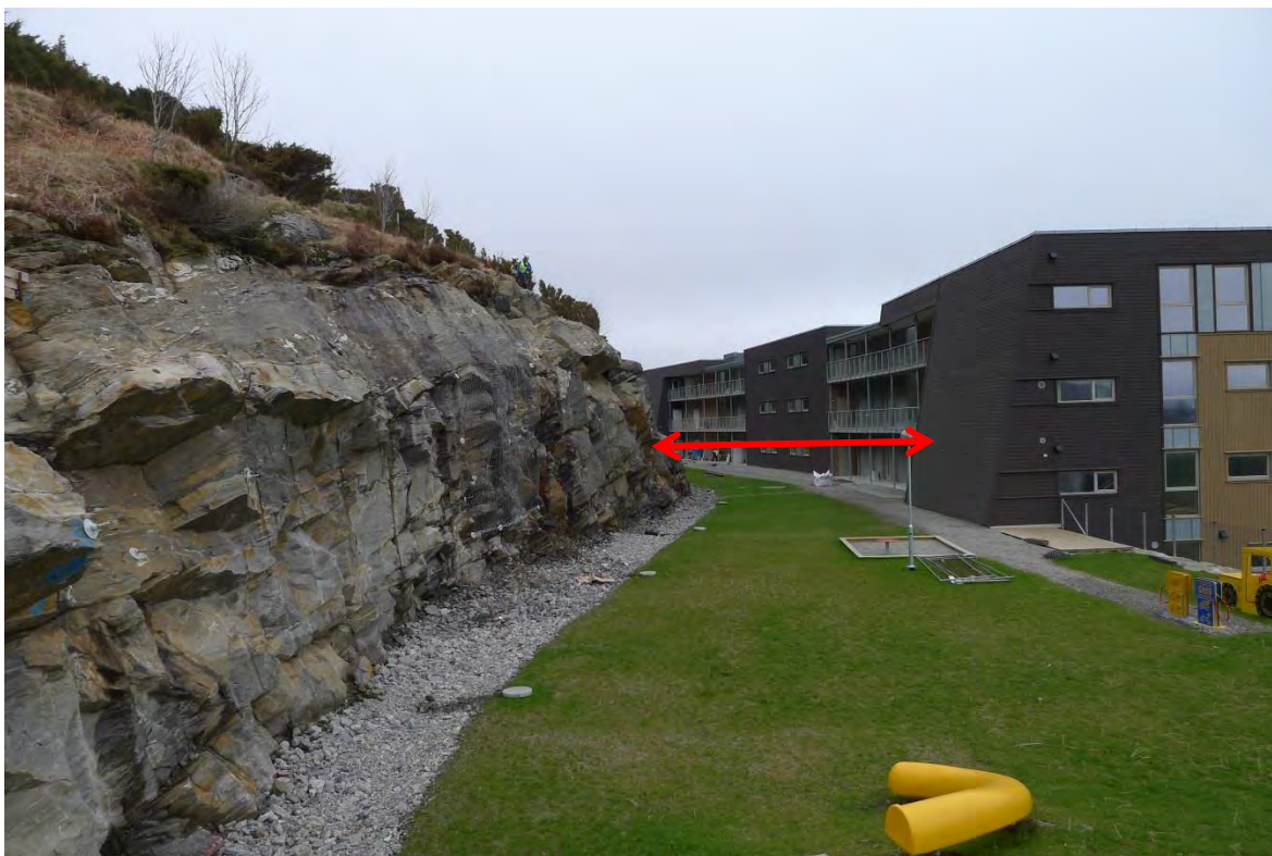
Figur 18: Det anbefales at eventuelle bygg i området har god avstand ut fra sprengt bergskjæring. Dette er utført ved nybygd terrasseblokker i midtre del av området som vist på bildet. Stabilitet og sikring av viste bergskjæring er ikke med i denne vurderingen og forutsettes ivarettatt av utbygger.
