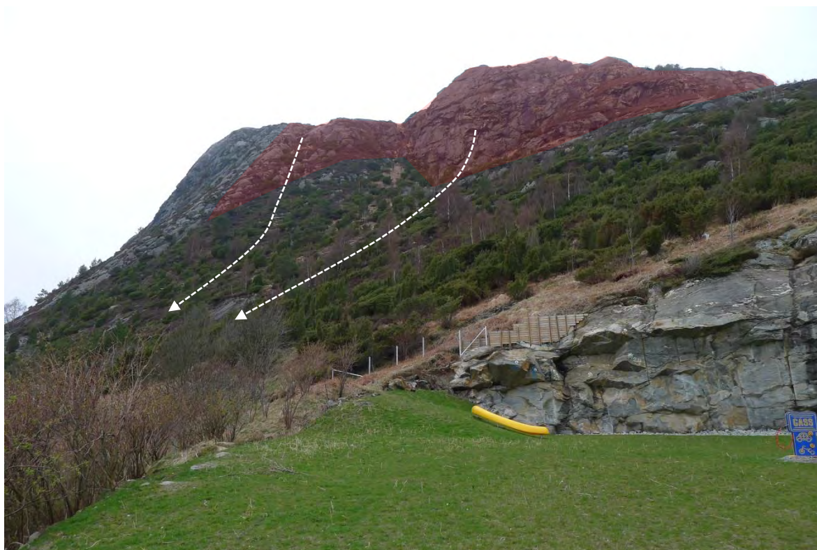
Figur 16: Bildet er tatt mot Alvanuten i midtre del av området. Det viser potensielt løsneområde og skredbaner (rød skravur og hvite piler). Det er mange mindre bergskrenter som ikke er så markerte i terrenget. Noen av disse ble kartlagt som potensielle løsneområder.
